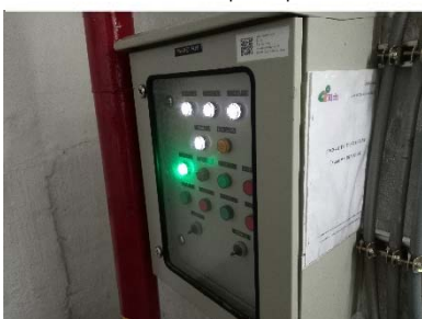
ตู้ควบคุม Transfer Pump
